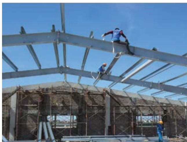
CÔNG TRÌNH NHÀ XƯỞNG
